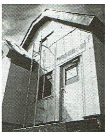
▲冬季出入り用梯子設置の門内非難小屋
